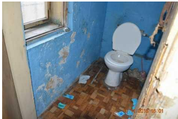
32. interiér prázdny byt
