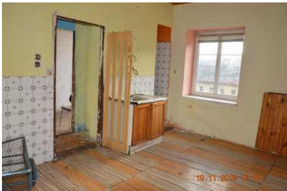
31. interiér prázdny byt
